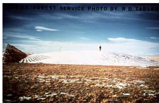
防雪柵の背後にできる雪の吹きだまりを水資源に利用 雪解け水を溜め池に導いて灌漑農業の水源に利用
