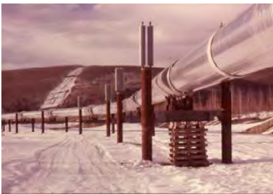
熱サイホン発電発想の原点となったアラスカ 石油パイプライン橋脚に熱サイホンが使われた
